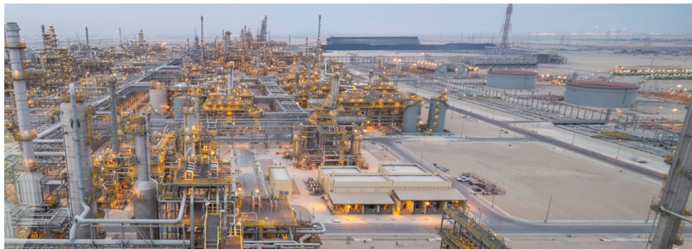
Tecnimont e Tecnimont
