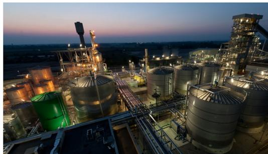
Gli enzimi - spiega la società chimica del gruppo ENI - sono fondamentali per la produzione di zuccheri di seconda generazione, in quanto permettono la saccarificazione delle biomasse. Questi zuccheri vengono poi trasformati, attraverso processi di fermentazione, in etanolo cellulosico - "bioetanolo advanced" - o in altri intermedi chimici. Il bioetanolo, prodotto attraverso la tecnologia Proesa viene utilizzato per la formulazione di carburanti con componente rinnovabile.
