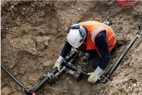
L'operatore francese della rete servizi gas GRDF ha posato a Clermont-Ferrand un chilometro di tubi per la distribuzione di gas in polietilene ad alta densità (HDPE) prodotto con materie prime biobased al posto di quelle fossili, attribuite mediante bilancio di massa certificato ISCC Plus.
