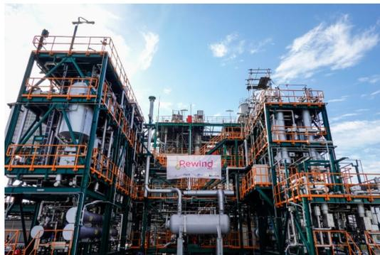
Frutto dell'espansione e ottimizzazione dell'impianto pilota KHP (Kitakyushu Hibikinada Pilot) di Jeplan, l'unità opera a livello semi-industriale, con una capacità di trattamento pari a 1.000 tonnellate annue.
