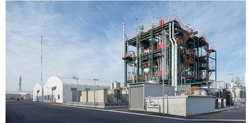
Il processo selezionato per il nuovo progetto si basa su una glicolisi del polimero seguita da una purificazione spinta, capace di rimuovere impurità organiche e inorganiche, al fine di ottenere monomero BHET (bis (2-idrossietil) tereftalato) pronto per essere riutilizzato in un impianto di polimerizzazione e ottenere così PET anche di grado alimentare.
