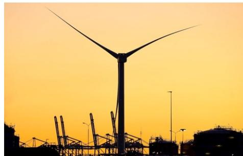
Alto 160 metri (260 metri la massima estensione in altezza delle pale), con un diametro delle pale di 220 metri (ognuna lunga 107 metri), il generatore è in grado di produrre 12 megawatt di energia elettrica, sufficiente a coprire il fabbisogno di 16mila abitazioni della regione, il 42% in più di ogni altra turbina oggi in funzione. In un anno, una sola di queste turbine è in grado di produrre fino a 67 GWh.
