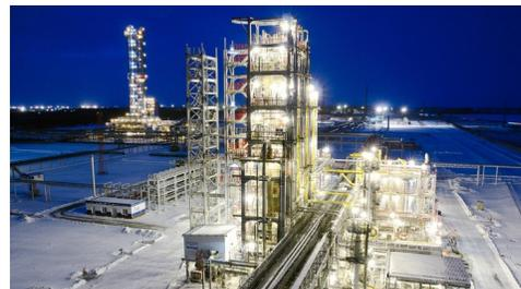
L'impianto, sito a Omsk, nella parte sud-occidentale della Siberia, ha una capacità produttiva pari a 218.000 tonnellate annue di polipropilene (processo Spheripol di LyondellBasell). La materia prima, propilene da propano, viene prodotta presso la vicina raffineria di Gazprom Neft, mentre Sibur si occupa della distribuzione delle resine in Russia e nei paesi del CSI.
