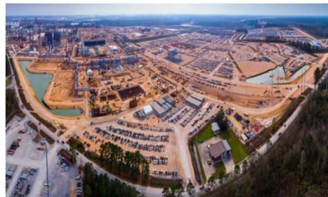
Si avvicina così l'entrata in produzione della nuova unità, che utilizza tecnologia di processo Unipol PE (licenziata da Univation Technologies) per una capacità produttiva pari a 470mila tonnellate annue. Un secondo impianto per polietilene a bassa densità (LDPE) con tecnologia ExxonMobil, da 420mila tonnellate annue, entrerà in funzione entro la fine di quest'anno.
