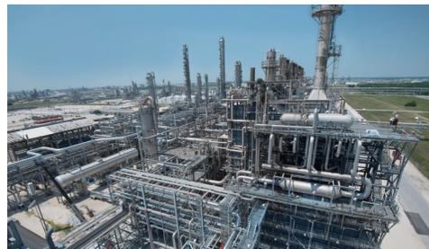
Sviluppata nei laboratori di Francoforte e Ferrara, la tecnologia di processo cascade gas phase Hyperzone PE si basa sul reattore a circolazione Multizone e consente la produzione di un'ampia gamma di polietileni ad alta densità multimodali.
