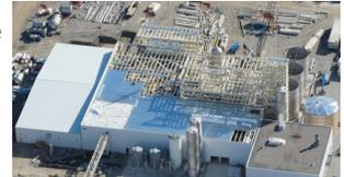
Mancano solo la messa a punto e il controllo di alcune strumentazioni, l'isolamento delle ultime condutture, alcuni lavori di pavimentazione all'esterno, la rimozione dei ponteggi e la posa di alcuni pannelli di rivestimento esterno dell'edificio.
