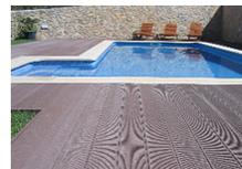
La resistenza all'umidità ed alle muffe rende questo materiale ibrido una buona soluzione per la realizzazione di pali da ormeggio, pontili, passeggiate lungomare o deck per piscine, tutti ambienti dove la percentuale di umidità Ã molto elevata.
