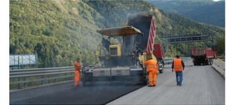
Secondo i test condotti dall'ateneo piemontese, l'uso di gomma da PFU come additivo nei conglomerati bituminosi per realizzare "asfalti modificati" apporterebbe un significativo abbattimento del rumore da rotolamento, generato dai veicoli in transito, assicurando una maggiore durata nel tempo delle pavimentazioni.
