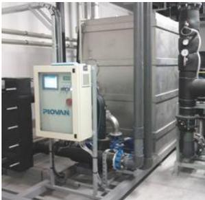
Dopo aver valutato diverse opzioni, i tecnici hanno deciso di adottare, in particolare, il free cooling per la refrigerazione del sistema idraulico delle macchine di processo, il cui carico è pari ad oltre il 60% del totale e dove è possibile utilizzare per tutto l'anno acqua di raffreddamento con temperatura massima di 30°C.
