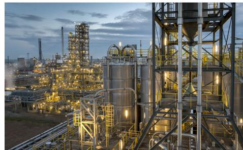
Il cracker che non verrà riaperto al termine dei lavori, per essere in seguito smantellato, è Olefins 3, avviato nel 1973 e ampliato fino ad arrivare a una capacità produttiva di 550.000 tonnellate annue di etilene e 260.000 t/a di propilene.
