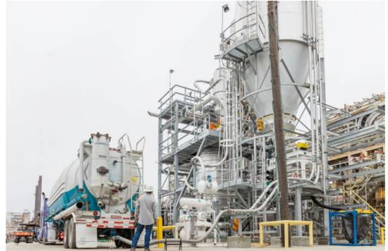
L'unità utilizza la tecnologia proprietaria Exxtend per trasformare rifiuti plastici difficili da riciclare per via meccanica, oggi conferiti in discarica o a incenerimento, in materie prime sostitutive di quelle fossili per produrre intermedi chimici e polimeri. La capacità di trattamento dell'impianto texano è pari a 80 milioni di libbre, equivalenti a oltre 36mila tonnellate annue di rifiuti.
