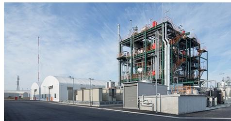
Battezzato Rewind PET, il processo si basa su una glicolisi del polimero seguita da una efficiente purificazione, capace di rimuovere impurità organiche e inorganiche, al fine di ottenere monomero BHET (bis (2-idrossietil) tereftalato) pronto per essere riutilizzato in un impianto di polimerizzazione e ottenere così PET anche di grado alimentare.
