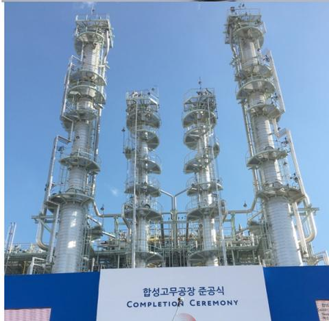
Lotte Versalis Elastomers, joint-venture tra Versalis e Lotte Chemical, ha inaugurato oggi a Yeosu, in Corea del Sud, il nuovo polo chimico integrato per la produzione di elastomeri EPDM, s-SBR (gomma butadiene-stirene in soluzione) e polibutadiene (BR), con capacità complessiva pari a 200mila tonnellate annue. I prodotti sono destinati ad applicazioni negli pneumatici e altri componenti automotive, modifica di polimeri stirenici e stampaggio di articoli tecnici.
