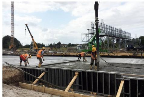
Nel cantiere si stanno posando 1100 metri cubi di cemento per creare una piattaforma sul Rastatter tunnel su cui poi saranno montati i binari. La piattaforma è lunga 100 metri e spessa un metro. In una seconda fase sarà posata una seconda piattaforma.
