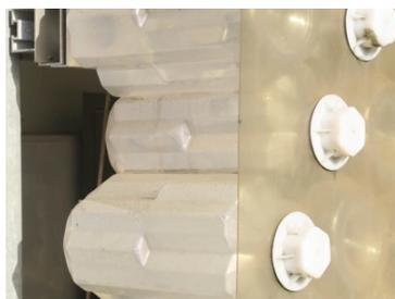
Per realizzare la facciata di EcoARK (questo il nome dell'edificio), le bottiglie non sono state usate tal quali, ma riciclate e con il PET così ottenuto sono stati soffiati nuovi elementi che, pur ricordando la forma di una bottiglia, presentano una struttura più resistente al carico e speciali scanalature che agevolano l'assemblaggio incastro, richiedendo solo una quantità minima di adesivo siliconico per la sigillatura. Per agevolare l'installazione, gli elementi sono riuniti in
