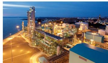
Le due unità, con capacità produttiva pari a 450.000 t/a di PP ognuna, utilizzeranno le tecnologie di processo LyondelBasell Spheripol e Spherizone.
